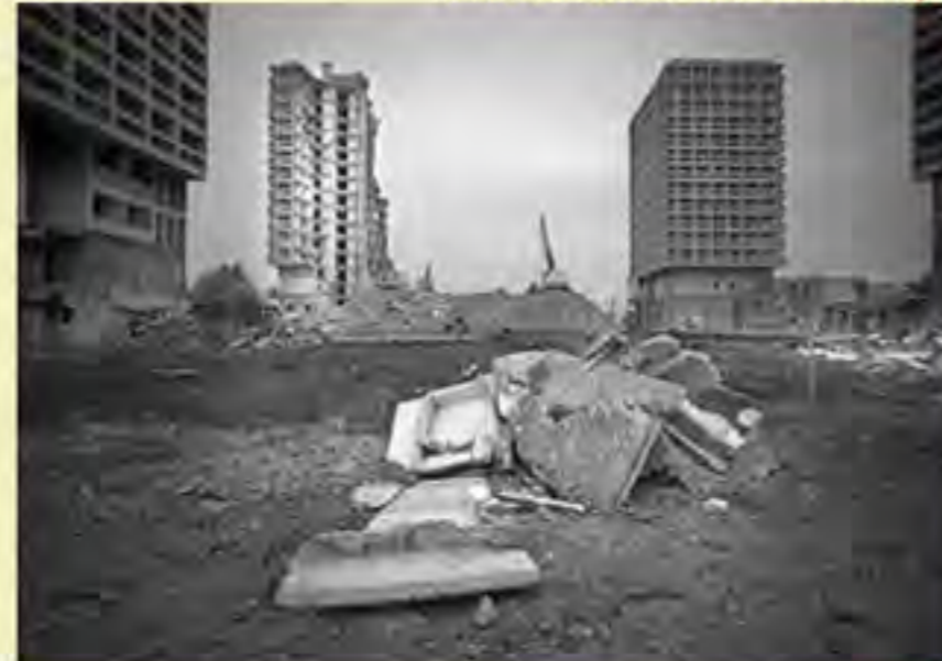
Tours Lavoisier: DURING demolition (D)
