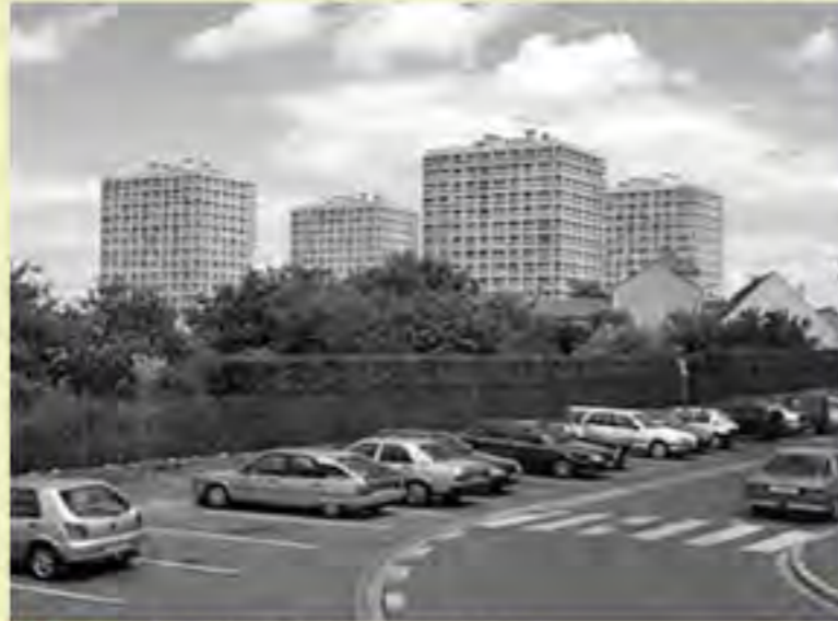
(A) Tours Lavoisier: BEFORE demolition
