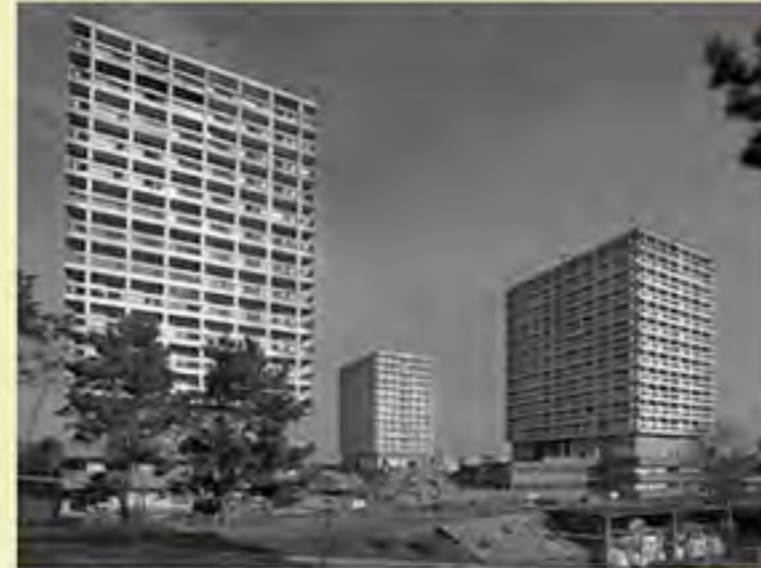
Tours Lavoisier: BEFORE demolition (B)
