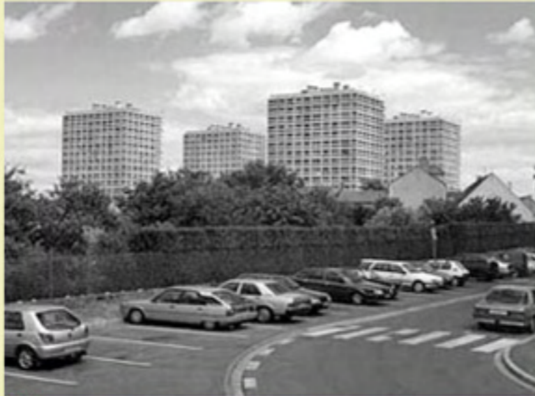
(A) Tours Lavoisier: BEFORE demolition
