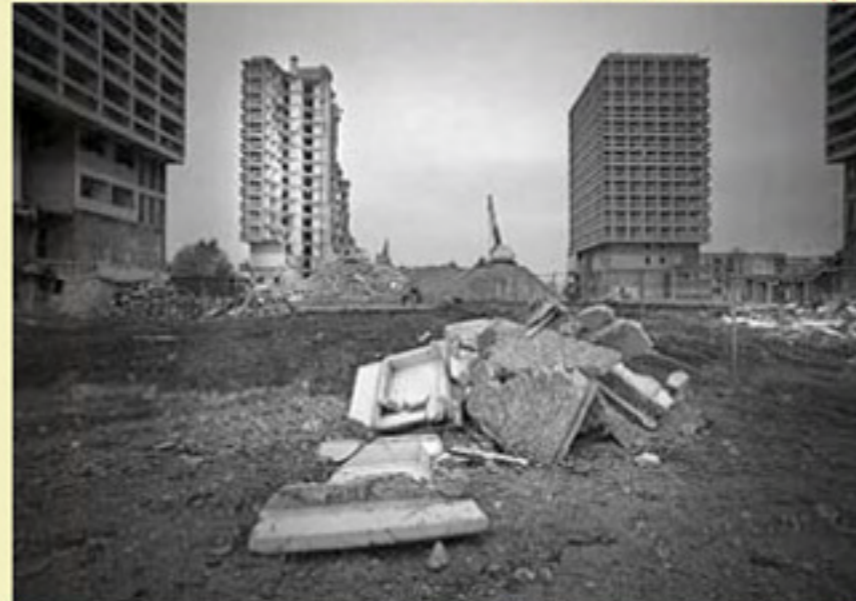
Tours Lavoisier: DURING demolition (D)
