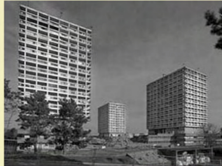
Tours Lavoisier: BEFORE demolition (B)
